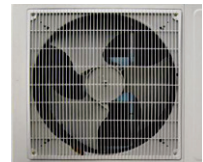
An den Ventilator-schaufeln entstehen Wirbel und Druckschwankungen, die als Lärm abgestrahlt werden.
