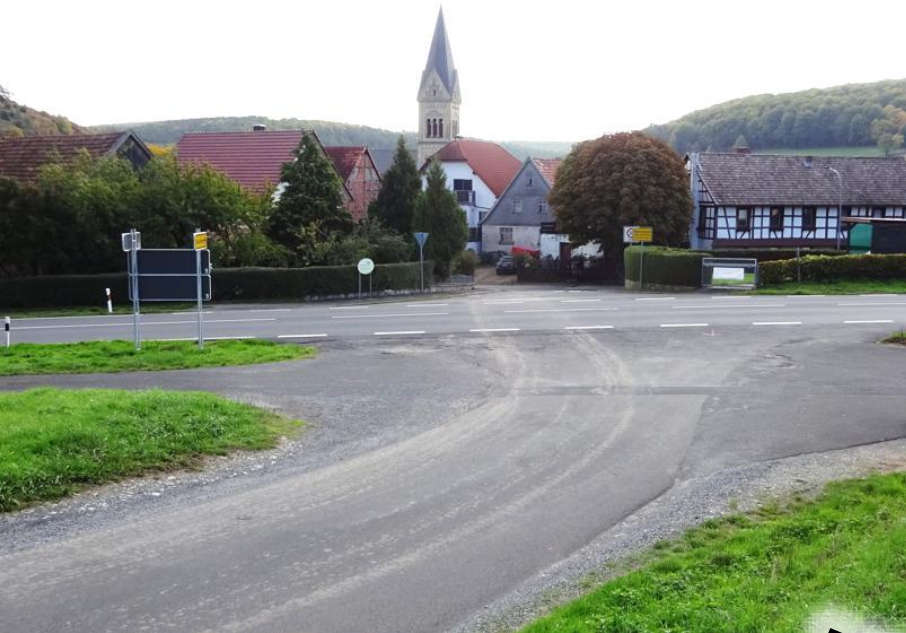
Obereschenbach: Ungesicherte Querung der B 27
